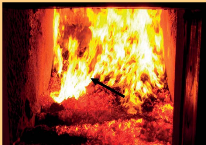
Excédent d'air avec hot spot (flèche) et scorification (ardens GmbH, 2017)
