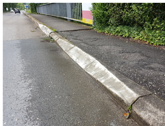
Trottoir couché pour rétablir la circulation de la petite faune à Chavannes-des-Bois (© Atelier Nature et Paysage)
