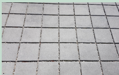
Pavés non jointés
