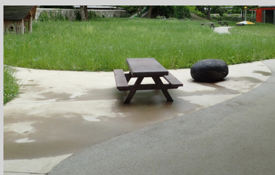
Revêtement en béton
