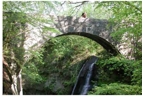
Pont du Covet, Chavannes-le-Chêne, 2005
