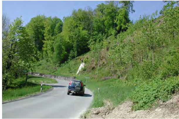
Route Ogens – Bercher, au lieu-dit le Martinet, 2005
