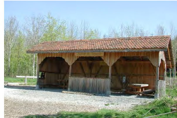
Refuge du bois des Brigands à Thierrens, 2005
