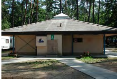
Cheseaux-Noréaz, 2005 Bâtiment en dur soustrait au régime forestier
