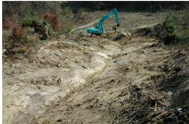
Assainissement de la zone de glissement et mise en place d'un système d'évacuation pour récolter les eaux de surfaces et éviter ainsi les infiltrations, Echallens, 2002
