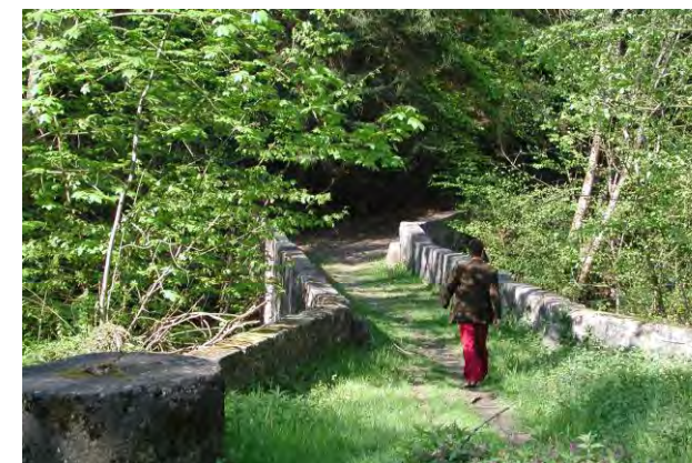
Pont du Covet, Chavannes-le-Chêne, 2005
