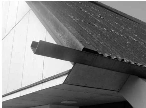
Toiture ondulée en fibrociment, photo IST
