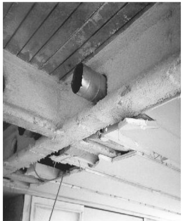
Flocage d'une structure métallique, photo IST
