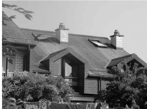
Tuiles en fibrociment, photo IST
