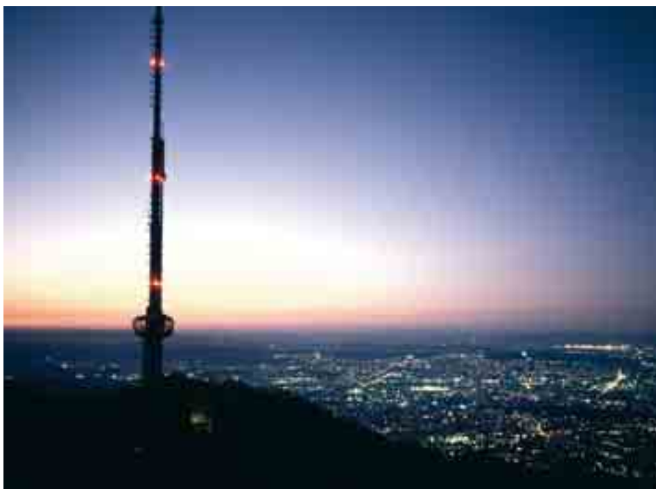
La ville de Zurich est desservie à partir de l'Uetliberg qui se trouve à proximité. La plupart des émetteurs de radiodiffusion sont implantés sur des montagnes ou des collines et les zones habitées ne sont donc pratiquement jamais exposées à des rayonnements intenses.
