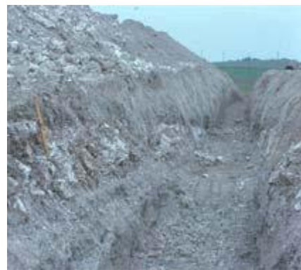
Suchy, tranchée du gazoduc: affleurement de marnes à bancs de calcaire lacustre: régosol (rendosol) -sol brun calcaire
