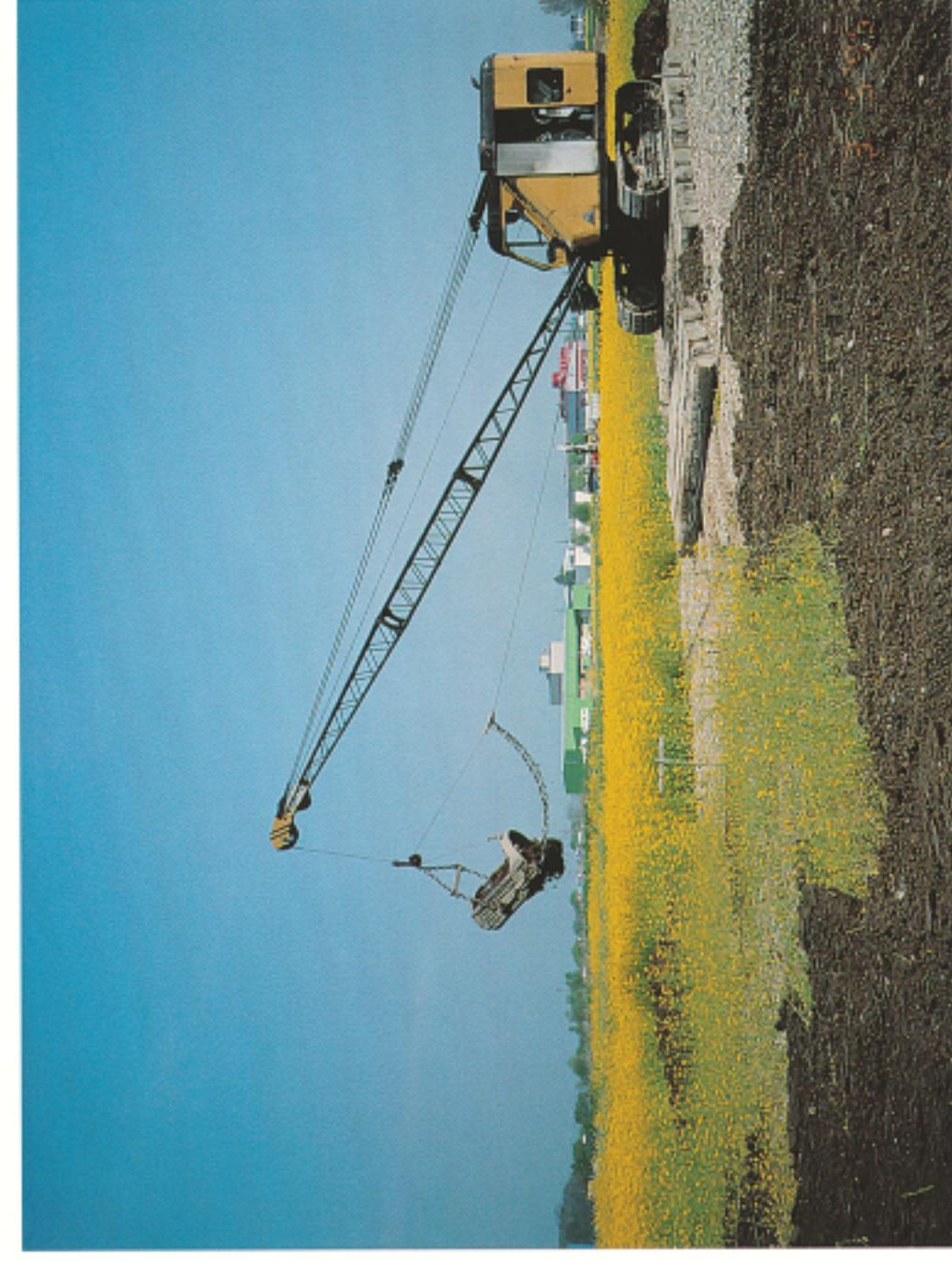
La remise en état d'un sol est une opération complexe et coûteuse. Il faut utiliser des machines adaptées telles qu'une pelle hydraulique, un bouteur version LGP ou une pelle à câbles (photo), et procéder à un terrassement intermédiaire. La remise en culture doit donc malgager le sol.
