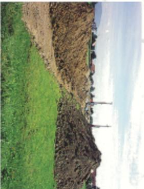
Entreposage provisoire de matériaux du sous-sol (à gauche) et de la couche supérieure du sol (à droite) juste avant l'ensemencement.
