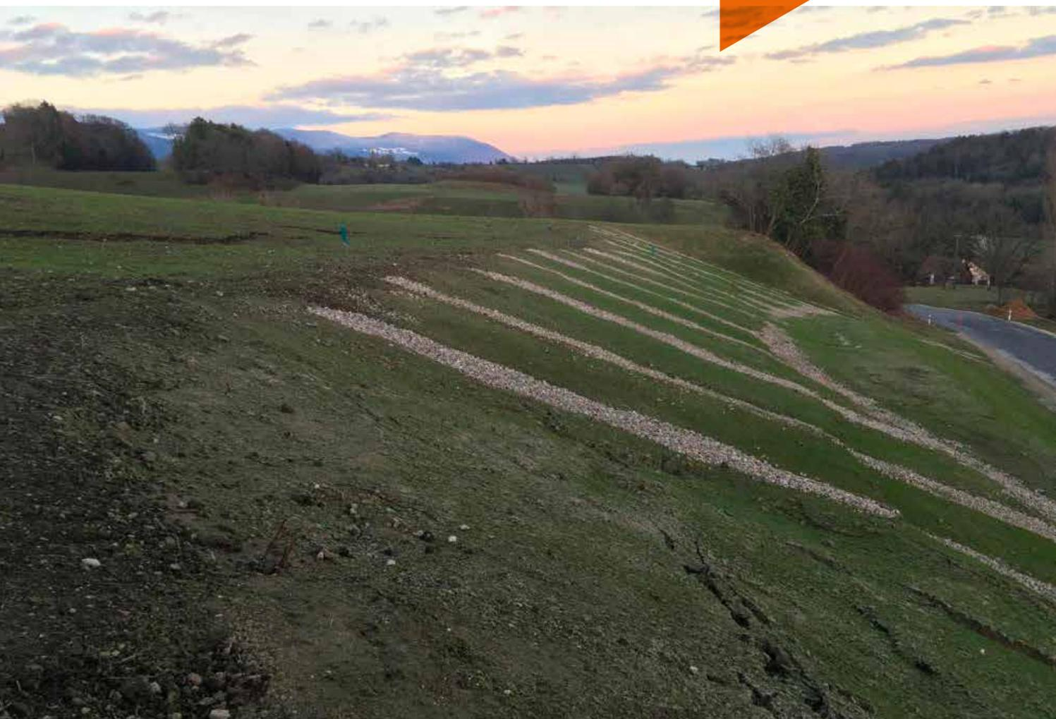
En étroite collaboration avec le Laboratoire de mécanique des sols de l'EPFL, la division infrastructures du canton de Vaud, a réalisé un projet pilote dans le nord-vaudois : la stabilisation d'un terrain par injection de ciment bactérien.
