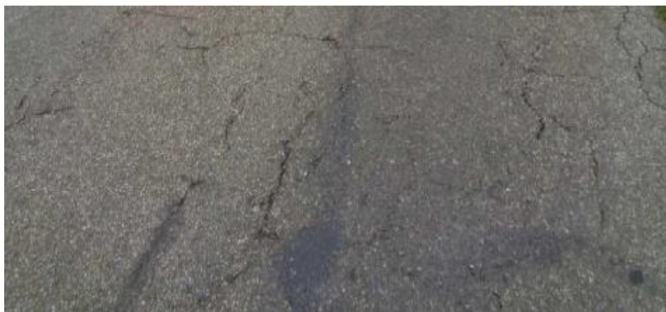
Figure 4 : Fissures dans le revêtement (voie direction Cugy)
