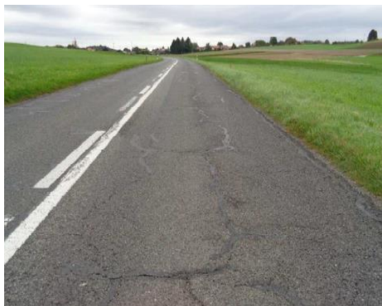
Figure 3 : Fissures dans le revêtement (voie direction Bottens)
