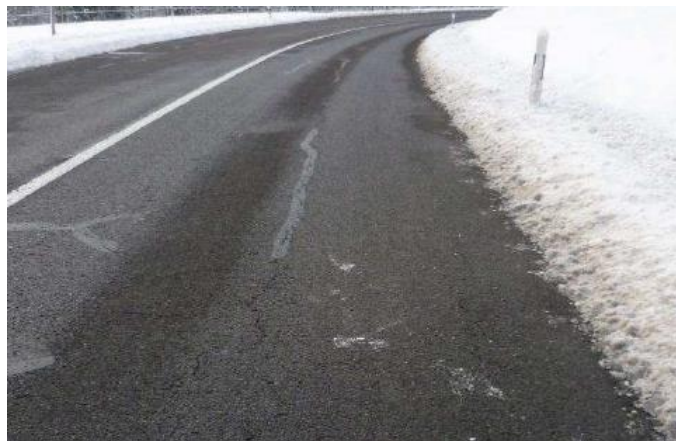
Figure 2 : Fissures dans le revêtement et affaissement de bord de chaussée droit (voie direction Cugy)
