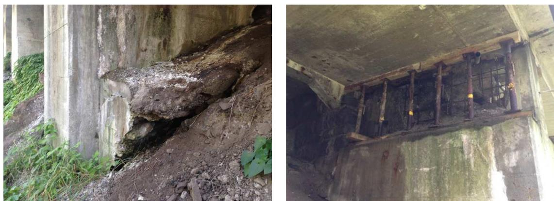
Figure 5 : Etat de dégradation des estacades
