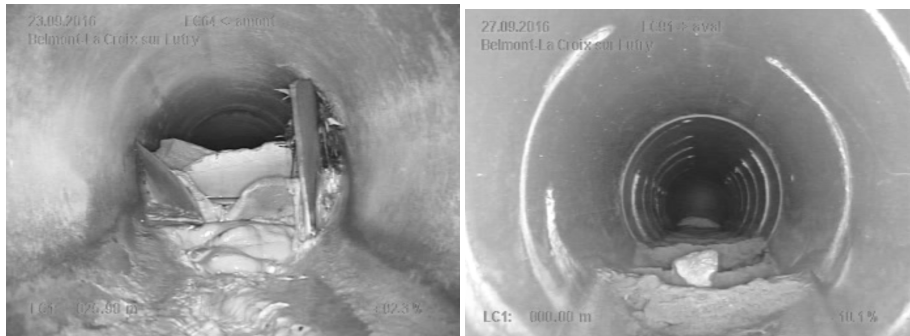
Figures 3 et 4 : Canalisations obstruées par le calcaire
