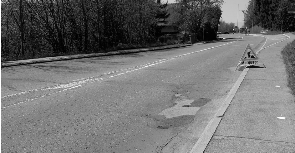
Figure 2 : Fissures et décollement du revêtement
