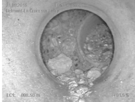
Figure 6 : Effets des glissements sur les canalisations.
