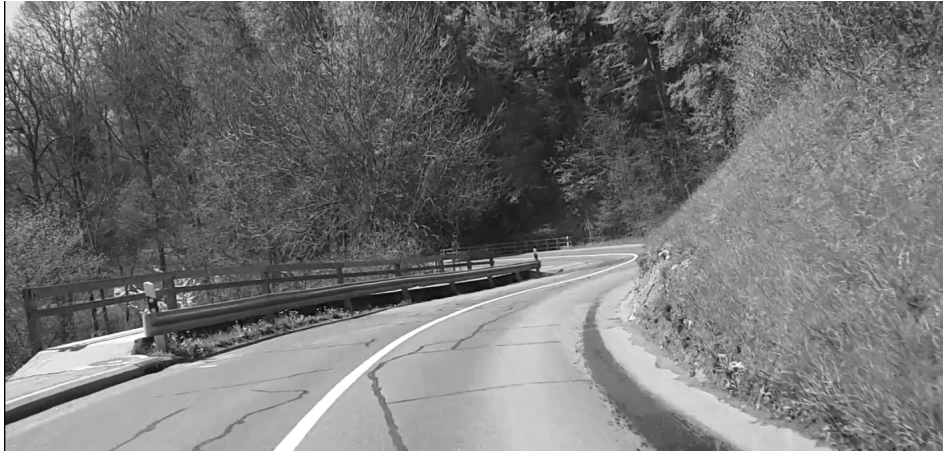
Figure 5 : Géométrie de la route, défaut de visibilité et passerelle en bois
