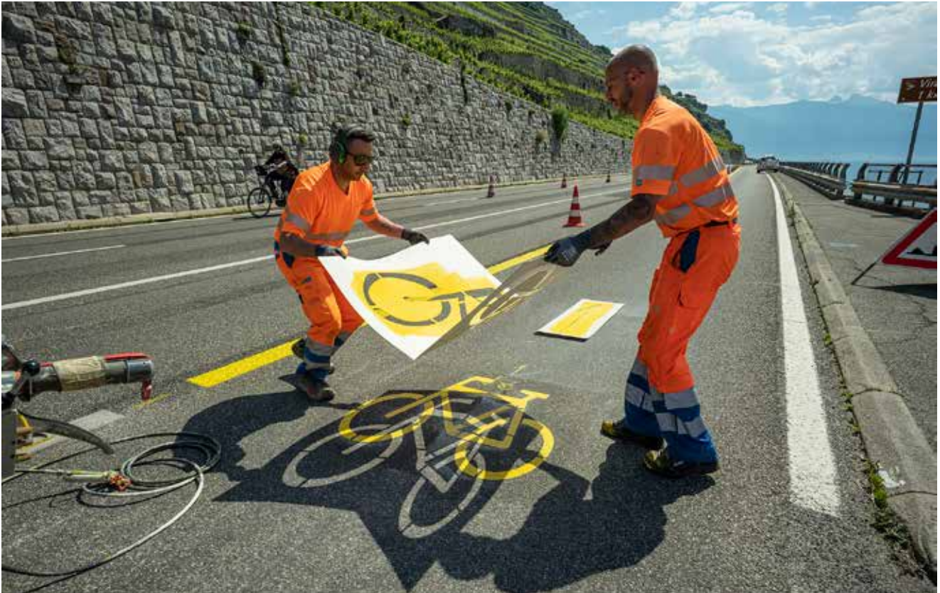
Route cantonale entre Lausanne et Vevey dans Lavaux, VD (crédit photo: Jean-Bernard Sieber, ARC Photo pour le compte de la DGMR)
