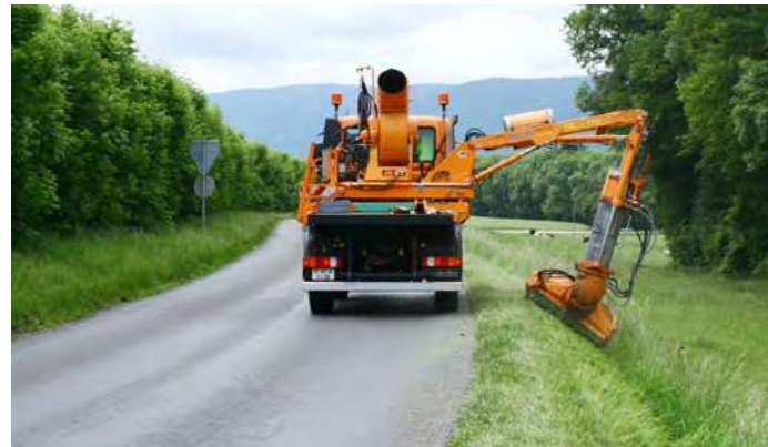
Engin porté permettant une pression au sol plus faible
