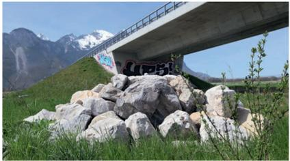
FF8 Passage à faune sous le viaduc de franchissement de l'A9 (printemps 2015)
