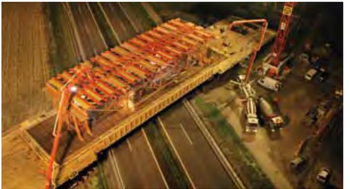
Bétonnage de la travée sur l'autoroute du viaduc sur l'A9 le 29 octobre 2010
