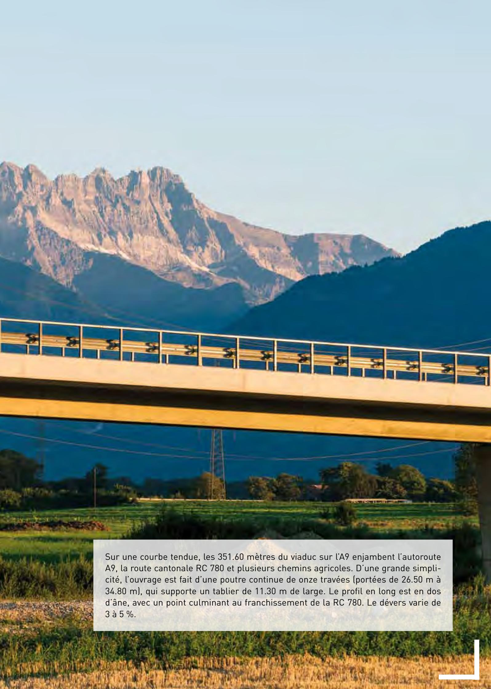
Sur une courbe tendue, les 351.60 mètres du viaduc sur l'A9 enjambent l'autoroute A9, la route cantonale RC 780 et plusieurs chemins agricoles. D'une grande simplicité, l'ouvrage est fait d'une poutre continue de onze travées (portées de 26.50 m à 34.80 m), qui supporte un tablier de 11.30 m de large. Le profil en long est en dos d'âne, avec un point culminant au franchissement de la RC 780. Le dévers varie de 3 à 5 %.
