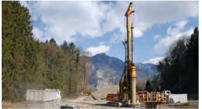
Travaux de pieux pour le pont sur le Gand Canal en mars 2010
