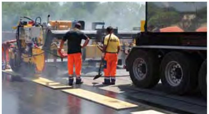
Pose de l'étanchéité du viaduc sur le Rhône en juillet 2012
