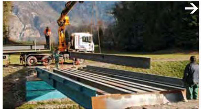
Piste de chantier - Pose du pont provisoire sur le Grand Canal le 4 décembre 2008
