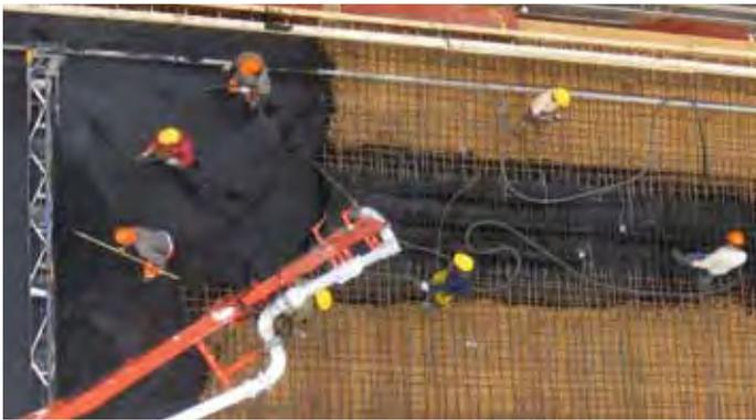
**Bétonnage du tablier du pont sur le Grand Canal le 3 novembre 2010**
