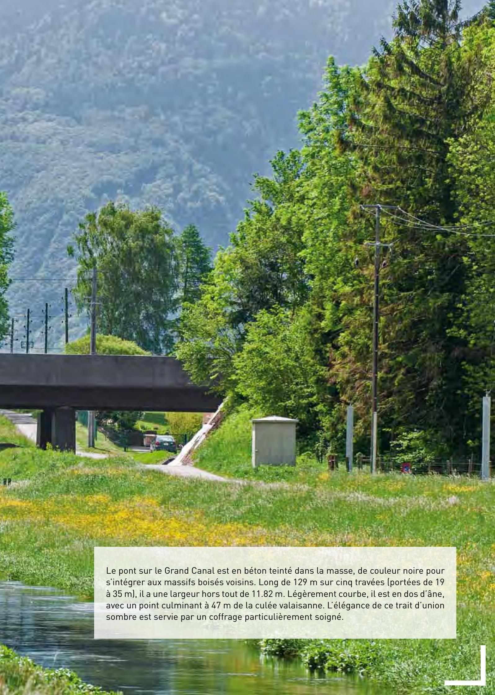
Le pont sur le Grand Canal est en béton teinté dans la masse, de couleur noire pour s'intégrer aux massifs boisés voisins. Long de 129 m sur cinq travées (portées de 19 à 35 m), il a une largeur hors tout de 11.82 m. Légèrement courbe, il est en dos d'âne, avec un point culminant à 47 m de la culée valaisanne. L'élégance de ce trait d'union sombre est servie par un coffrage particulièrement soigné.
