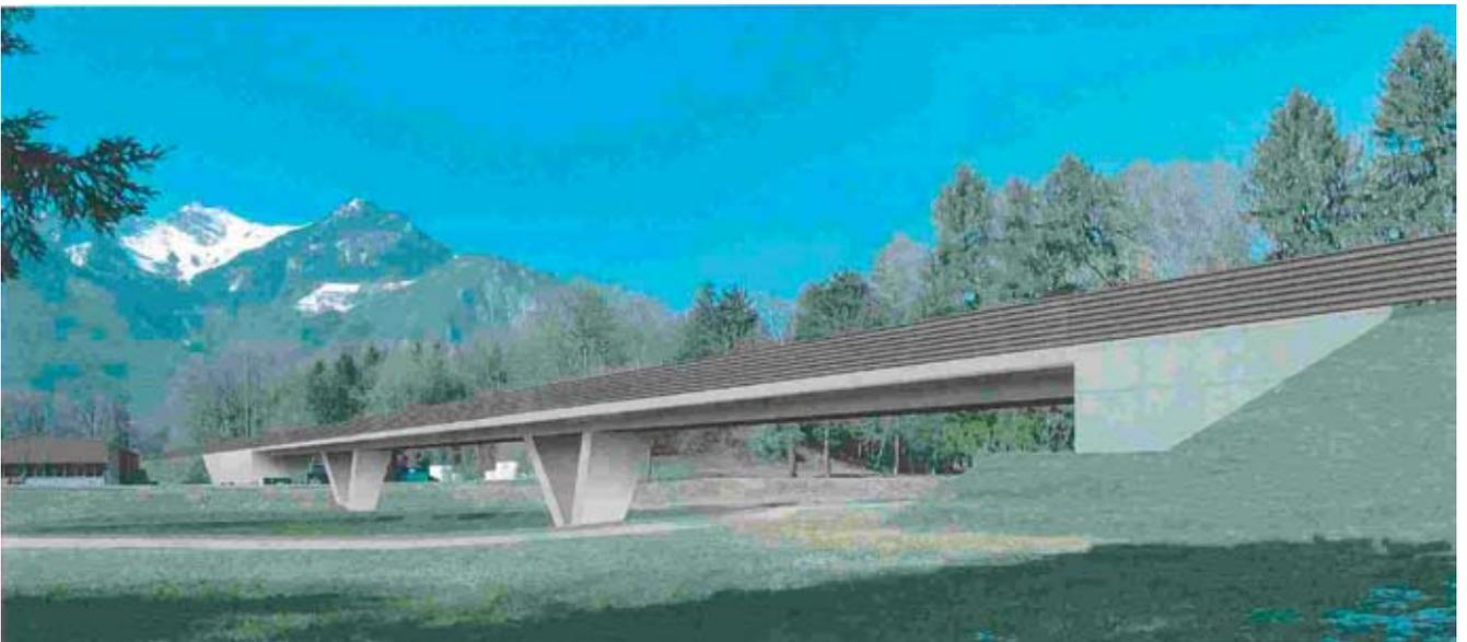
Le jury apprécie l'idée de base du pont qui franchit le canal en trois travées, avec une travée centrale clairement définie. Le traitement des culées est quelque peu banalisé. Il manque un langage commun entre ces dernières et les piles. Les détails ne sont pas suffisamment traités et la réponse apportée aux parois antibruit affaiblissent l'ouvrage.
