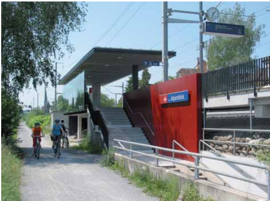
Chemin d'accès vers une gare régionale (environs de Zoug)
