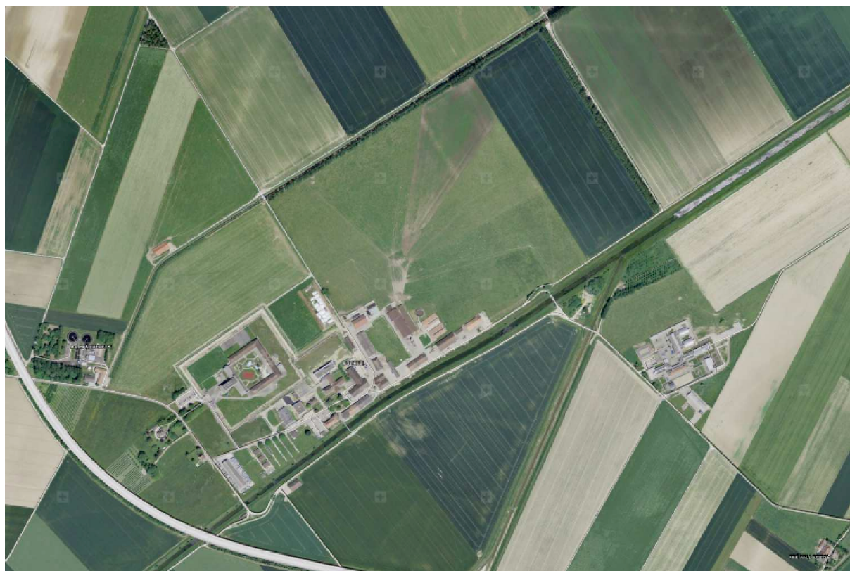
Figure 5.18 : Photo aérienne du secteur étudié
