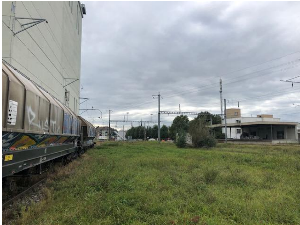
VUE ARRIERE-SILO LANDI – VOIES CFF
