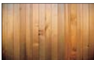
pose à rainure et languette
