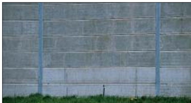
préférer une ossature en acier galvanisé à chaud ou de même teinte que le panneau
