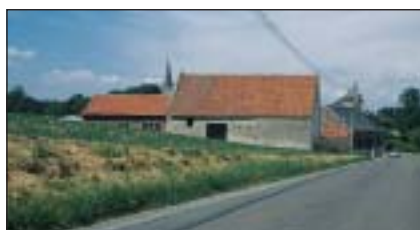
une toiture en tuiles traditionnelles
