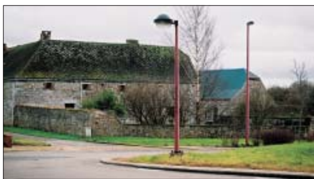
une couverture de toiture trop bleue
