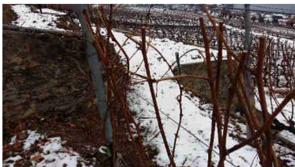
Aménagement d'un passage en supprimant un bout de mur © AGRIDEA
