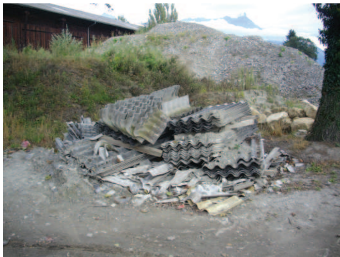
Plaques ondulées en fibrociment: prudence lors du démontage !
