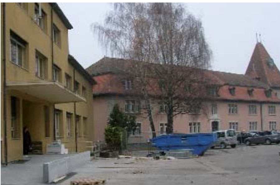
Dès le 19 décembre, les quatre «anciennes» préfectures d'Yverdon, Orbe, Grandson et La Vallée sont rassemblées au rez de chaussée d'un des bâtiments (premier plan) des anciennes casernes d'Yverdon, qui accueille déjà (arrière plan) le Tribunal d'arrondissement Broye-Nord vaudois.
