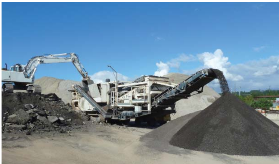
Concassage de matériaux bitumineux (Photo: Florian Zellweger)
