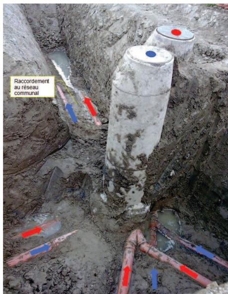
Une erreur trop fréquente : inversion des raccordements aux eaux usées et aux eaux claires.
