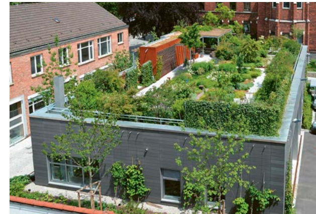
Les toitures végétalisées, comme celle de la Clinique des Diaconesses, à Augsburg en Allemagne, représentent un léger surcoût lors de leur création. Un investissement vite amorti étant donné les bénéfices déployés à différents niveaux: isolation thermique, économies d'énergie, rétention d'eau, rafraîchissement urbain, espaces de compensation écologique, épuration de l'air ou encore, amélioration des paysages et du bien-être des usagers.
