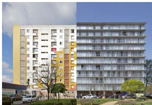
Lors du projet de rénovation des bâtiment GHI, dans le quartier des Grands parcs à Bordeaux, un jardin d'hiver a été ajouté en façade sud. Il fonctionne comme espace tampon entre l'intérieur et l'extérieur et améliore le confort thermique des logements.
