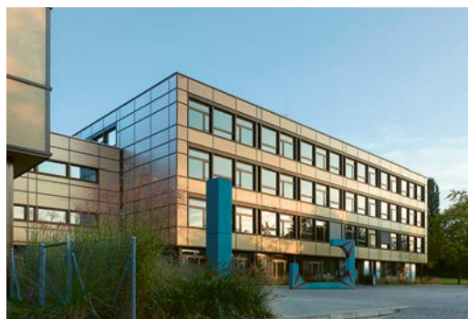
Conçu dans les années 1960, Le Gymnase d'Yverdon-les-Bains était l'un des plus grands gaspilleurs d'énergie parmi les bâtiments propriétés de l'État de Vaud avant son assainissement. Grâce au remplacement des fenêtres, à la rénovation du toit et des façades mais aussi à l'utilisation d'énergie renouvelable pour le chauffage, les économies d'énergie sont impressionnantes et dépassent les 70% pour les besoins en chaleur! Cerise sur le gâteau: le confort des usagers est sensiblement amélioré.
