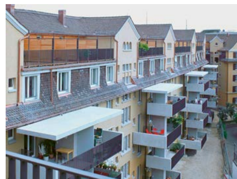
L'assainissement des bâtiments de la Röntgenstrasse, à Zurich, s'est accompagné d'une surélévation et de l'adjonction de balcons. Une façon réussie de réhabiliter des immeubles tout en améliorant le confort des habitants.
