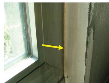
Photos 17-18 : Joints d'étanchéité intérieurs et extérieurs des fenêtres vétustes
