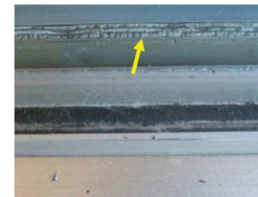
Photos 15-16 : Joints d'étanchéité intérieurs et extérieurs des verres vétustes
