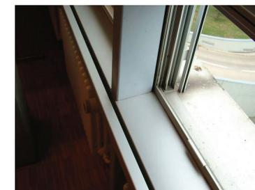
Photos 7-8 : Système d'ouvrant en imposte sans bande d'étanchéité à l'air en fermeture
