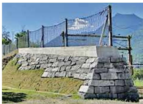
Figure 8 : Exemple de mesure active : le cas d'une digue de protection
