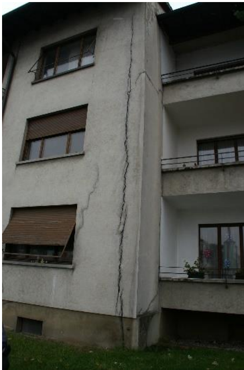
Figure 10. Bâtiment fissuré par un abaissement de terrain (Bâle-Campagne) et effondrement sous un trottoir (Jura neuchâtelois).
