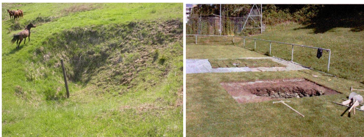
Figure 6. A gauche : abaissement dans la région de Couvet, NE (événement lent) ; à droite : effondrement (événement soudain) sur un terrain de football (Bex, VD).
