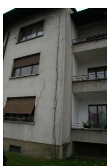
Effondrement soudain sous un trottoir et abaissement lent fissurant un bâtiment.
