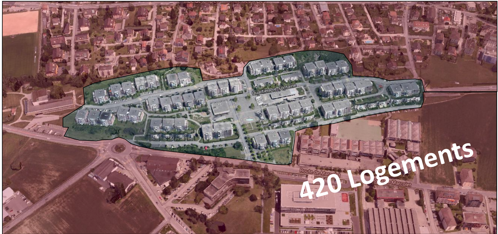
Quartier de Pré-Fontaine à Crissier
